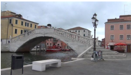
Ponte della Vena
